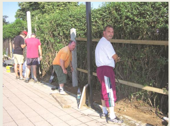
Ein komplett neues Zaunsfeld
