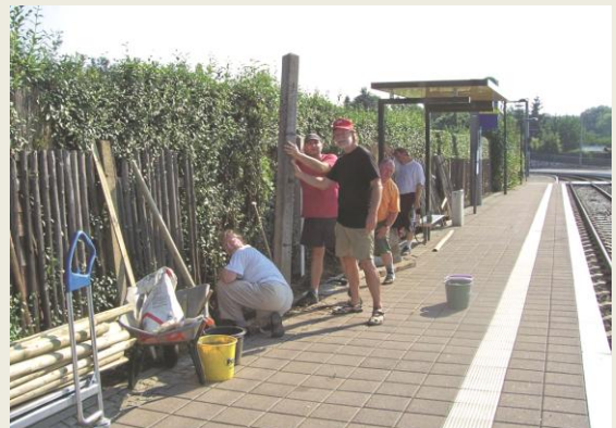
Austausch der alten Säulen gegen neue
