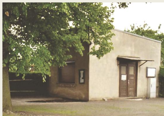
Vor der Renovierung
