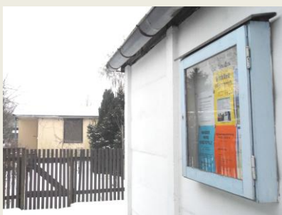
Der Schaukasten auf der Südseite Vordereingang
